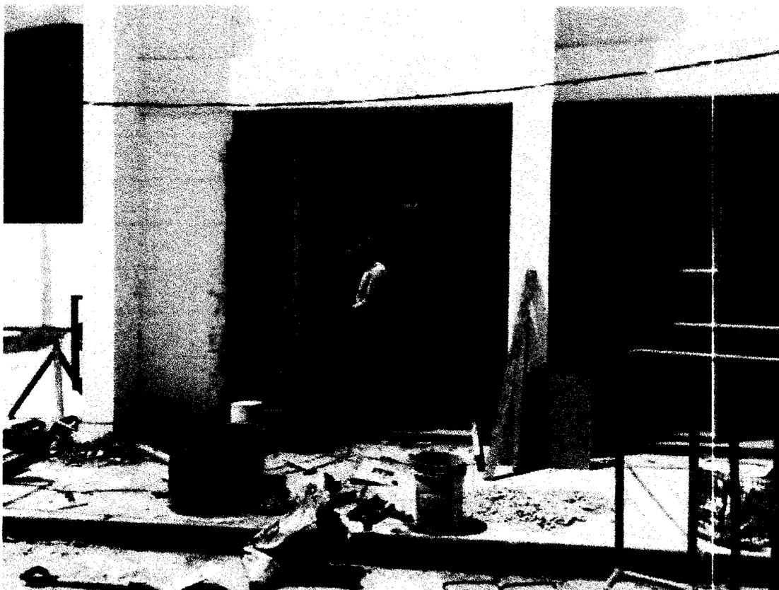
Fotografía N°21: Vista de tarrajeo de muro y columna en subestación.
